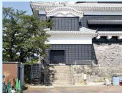
大天守出口の石段復旧完了状況
