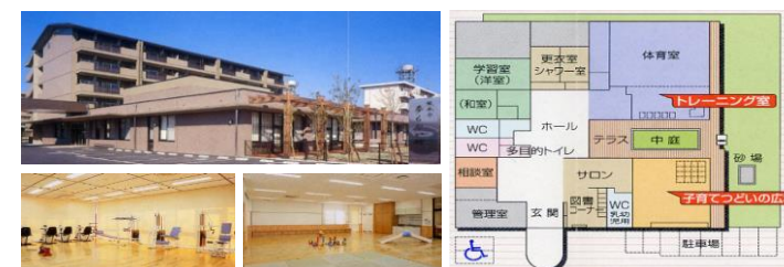
■ シルバーハウジングと福祉施設の合築事例 熊本市楠団地「夢もやい館」
