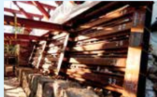
礎石を守るための土留め用の構台
