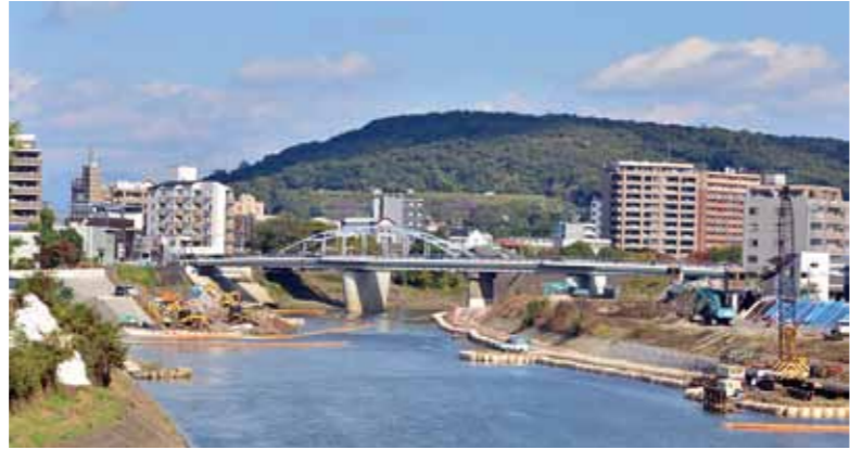
白川校区に接する白川は、現在、河川工事の真っ最中。より確実な水害防止のための対策は、校区にとっても安心なまちづくりの必須事項だ
