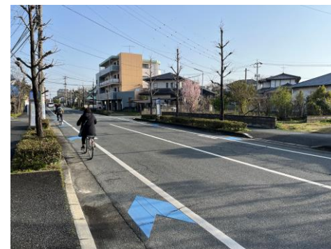
▲車道混在の整備状況(熊本空港線)
