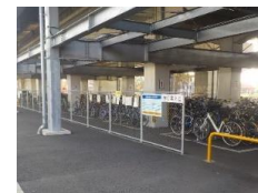
西熊本駅駐輪場
