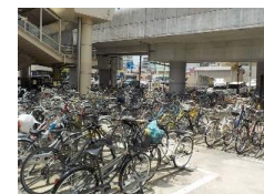
新水前寺駅東高架下駐輪場(増設)
