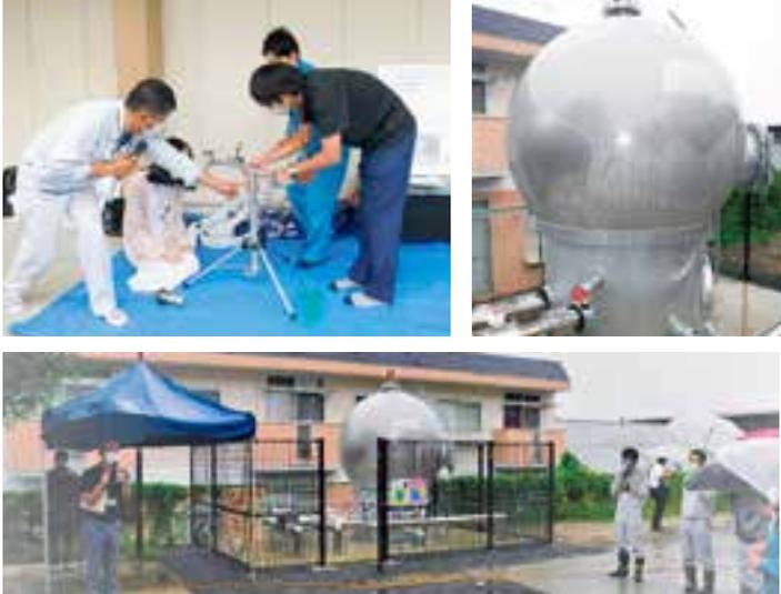
西区花園にある花園小学校に『貯水機能付給水管』を設置しました。見た目は大きなサッカーボールのような形で、上下水道局正面にも同様のものが設置してあります。貯水機能付給水管は、平常時は通常の給水管ですが、地震等の災害時などの断水時には、タンクに貯水している約4m<sup>3</sup>(2Lのペットボトル2,000本分)の飲料水を確保することができます。
