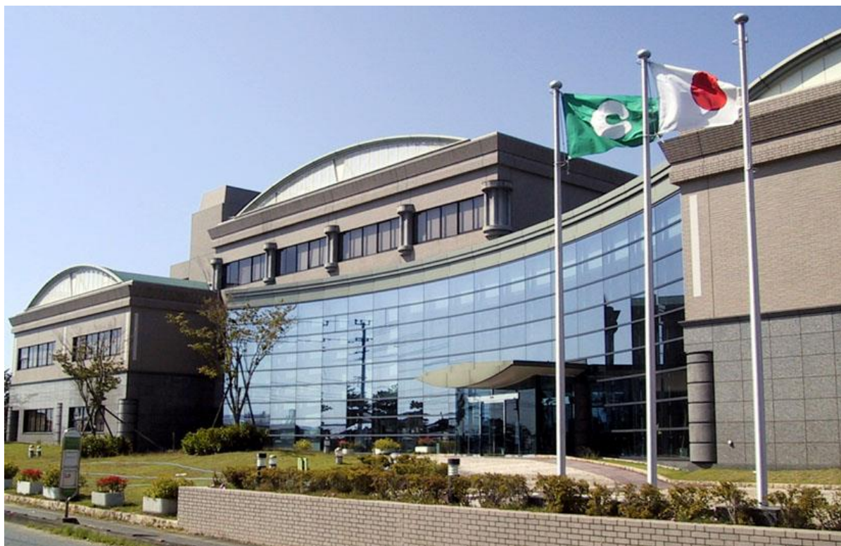
熊本市環境総合センターの全景
