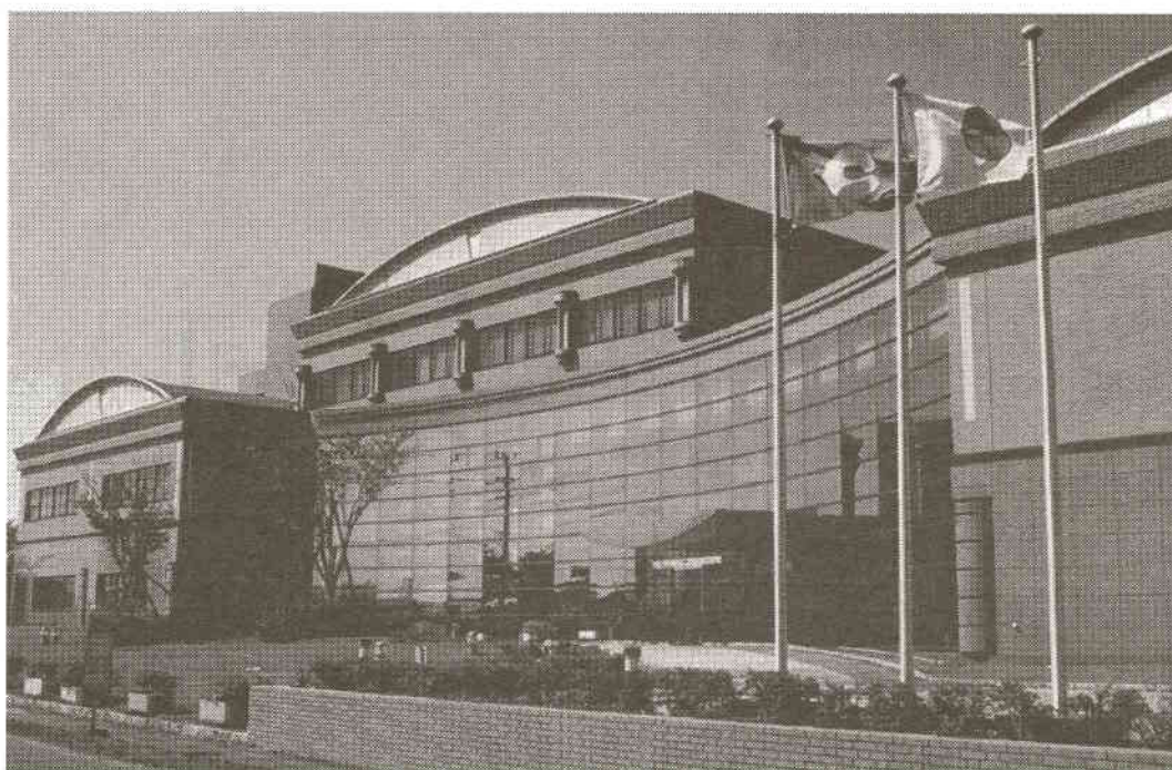
熊本市環境総合センターの全景
