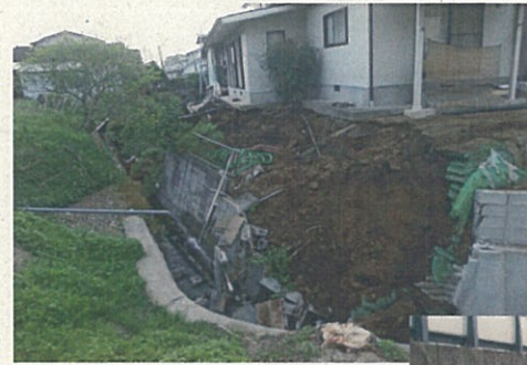
東区秋津町 ◆護岸の崩壊
