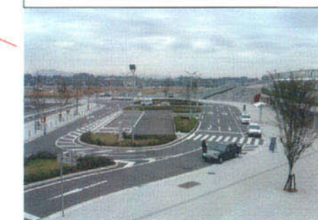
茨城県 牛久駅前広場 観光バスの送り迎えに適した広さ、かつ、バスやタクシー、 一般車等、車両交通の利便性に配慮した交通空間。 初めて訪れる人にとって、わかりやすい空間構成。 緑量は適所に境として配置し、見通しの良い、視界性の良い 空間を形成する。
