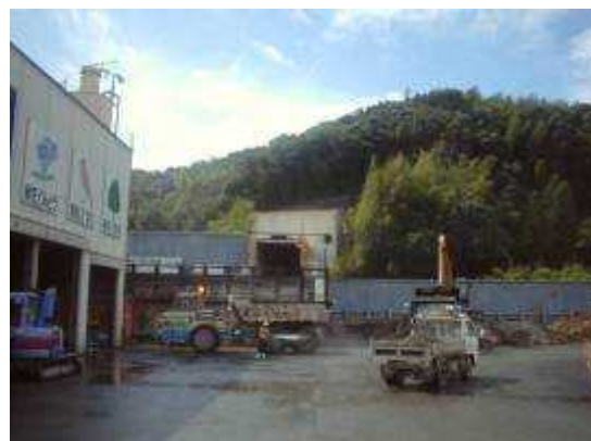
建設中の小塚トンネル(釜尾側)
