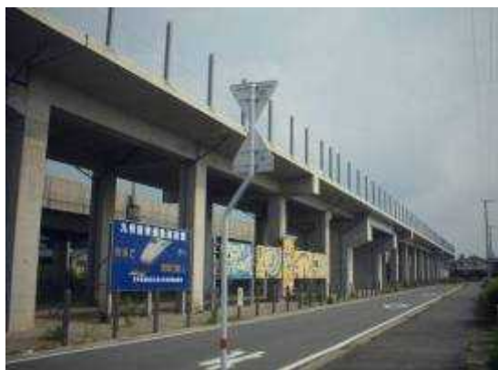
完成した島高架橋
