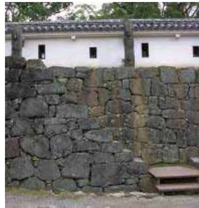
乱れ積みと打ち込みはぎ
