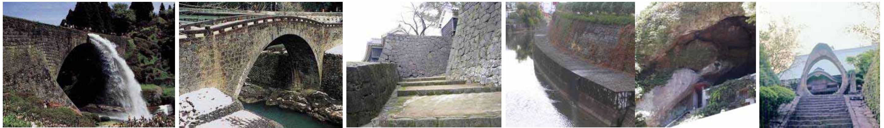
国の重要文化財 通潤橋 溶結凝灰岩
