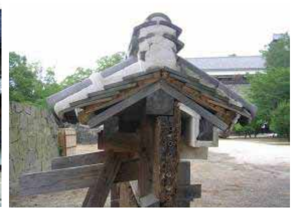
熊本城の屋根瓦
