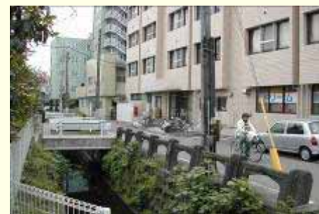
住宅地内の水路 (左岸)
