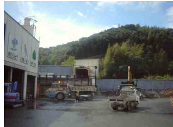
建設中の小塚トンネル(釜尾側)
