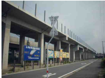
完成した島高架橋
