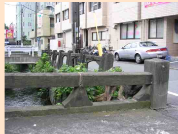
用水路の橋の高欄
