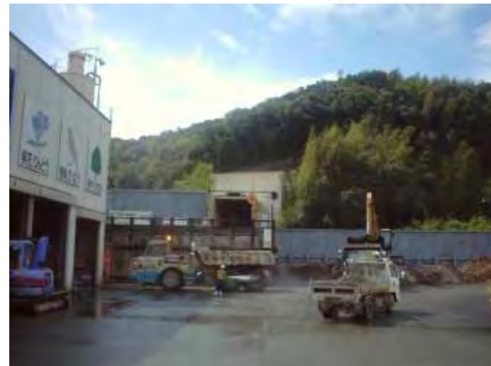
建設中の小塚トンネル(釜尾側)
