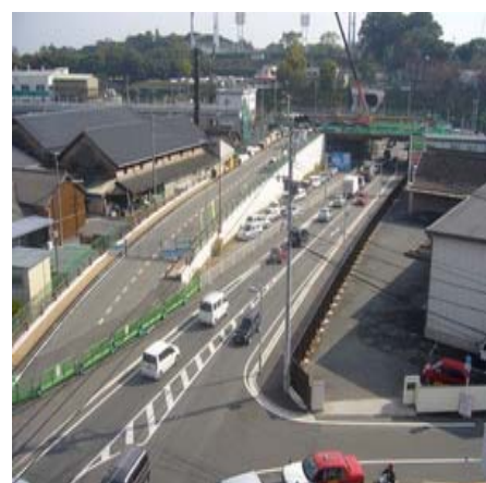
段山陸橋付近
