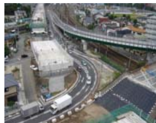
田崎陸橋付近
