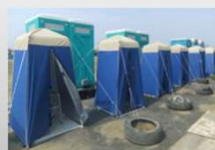
マンホールトイレ
