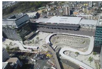
完成後の白川口駅前広場
