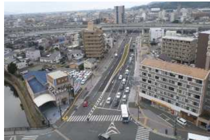
完成後の(都)熊本駅城山線
