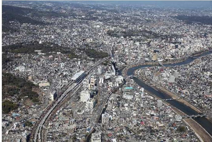
在来線高架化完了(H30年3月)
