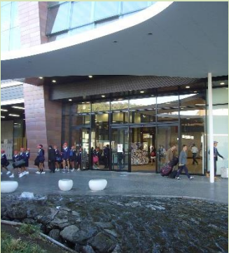
▲JR熊本駅西口(新幹線口)
