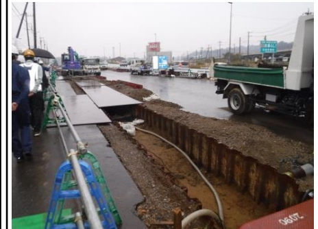
集水管設置工事の状況
