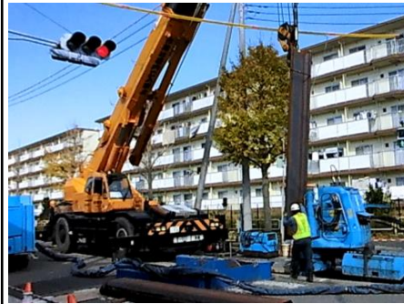
矢板打設工事の状況
