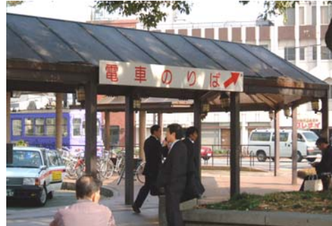
▲シェルターの設置後、大きなサインが付けられています。
