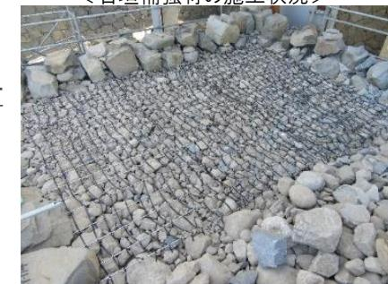
＜石垣補強材の施工状況＞
