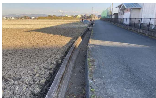
②敷地北側道路及び側溝
