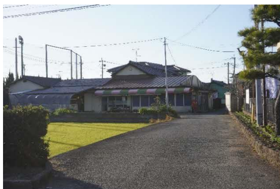
⑥敷地南側道路
