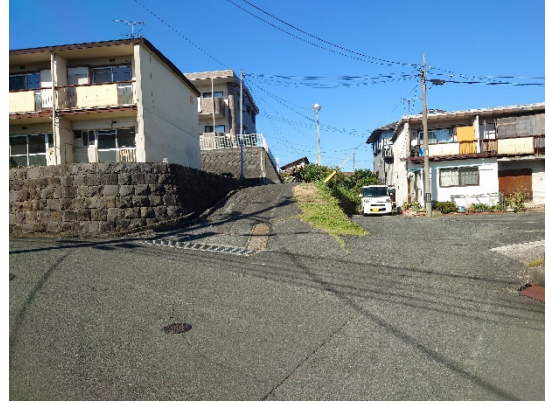
⑭南方より調査対象地 (左側：6棟、右側：5棟)
