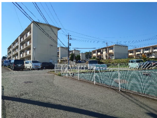
③南東方より調査対象地 (左から : No.4、No.3、No.2)
