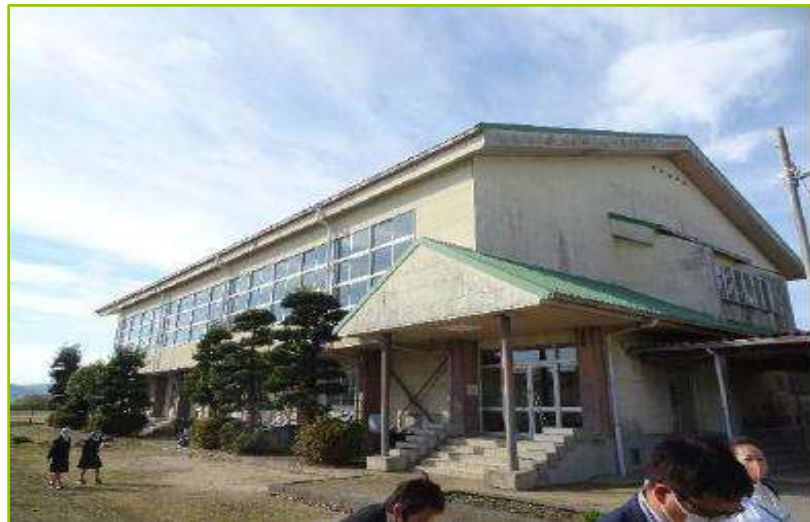
屋内運動場 (外観)
