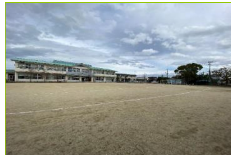
屋内運動場（外観）
