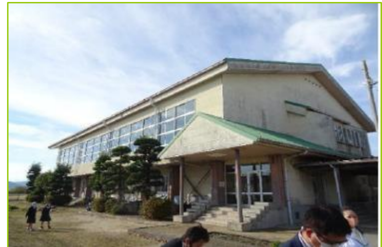
屋内運動場（外観）
