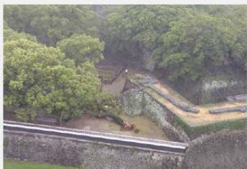
(文化財建造物沿いでの倒木) 手前は長堀
