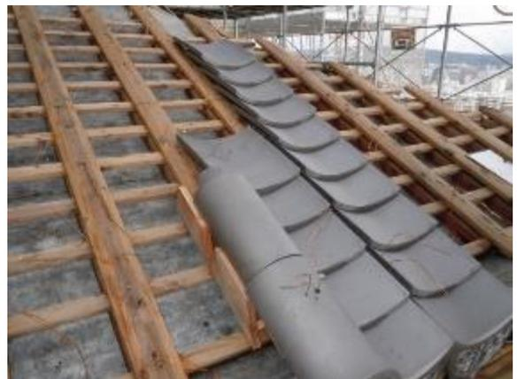
瓦設置 銅線緊結、釘止状況
