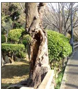
(写真19) 熊本城樹木維持管理(危険木)
