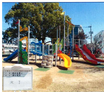
(写真20) 公園施設の更新(八王子中央公園)
