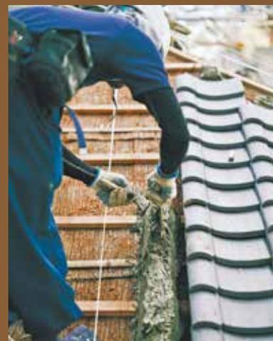
建物、外構の復旧工事着工。可能な限り、建築部材の再利用に努めました。また、調査により判明した新たな史実に基づき、復旧工事を行いました。
