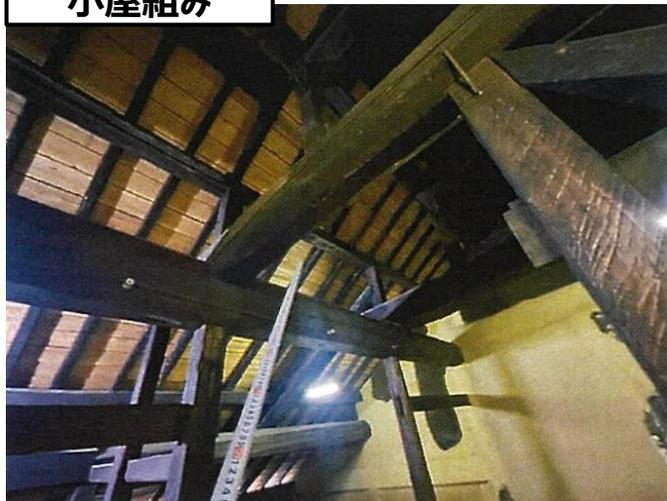
梁間方向の投掛け梁（長さは、約2800mm、幅は250mm）
