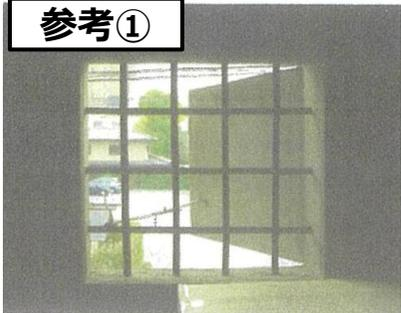
窓枠内に鉄の格子が交差。その外壁に薄い鉄板の方開き窓がある。
