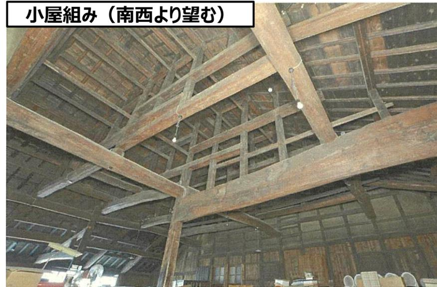
両端の梁成が約800の梁の上に束が立ち上がり、棟を支える。
