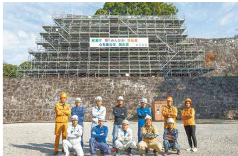
復旧に携わった工事関係者の皆さん
