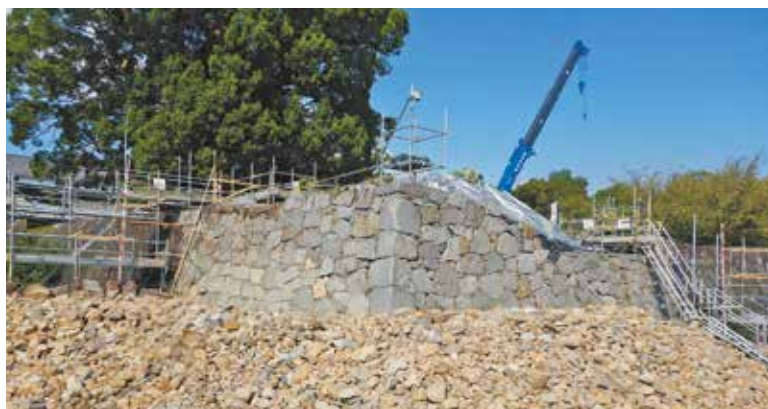
平成30年11月～令和元年5月 石垣解体によって姿を現した埋没石垣
