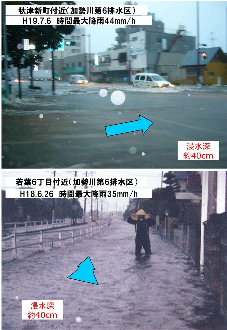
図 3-2 浸水被害状況の写真 (加勢川第6排水区)
