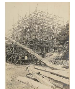
宇土櫓解体中
