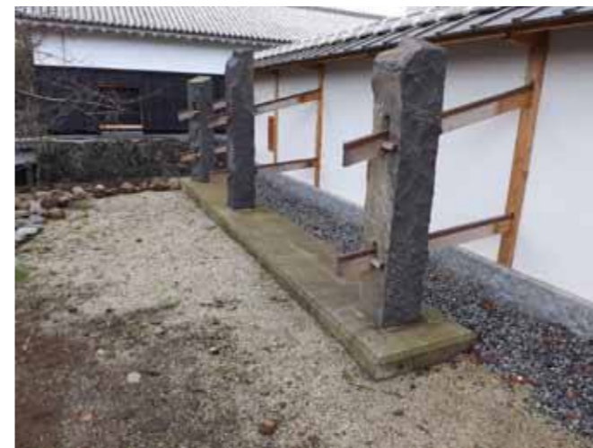
図6 馬具櫓及び続塀の控柱（基礎が見える部分）
