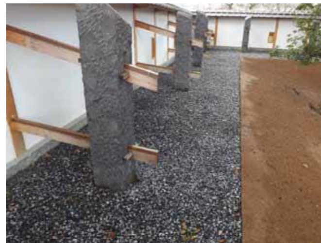
図5 馬具櫓及び続塀の控柱（基礎が見えない部分）
