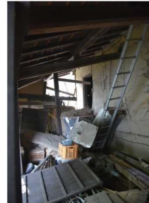
4 南面① 西側の石垣が崩れ、下屋の一部を押しつぶしている。南側に取り付く下屋が大きく傾斜している。
