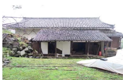
4 南面① 西側の石垣が崩れ、下屋の一部を押しつぶしている。南側に取り付く下屋が大きく傾斜している。
