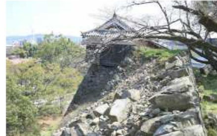
9 西面 平櫓西面の石垣には大きな孕み出しは見られなかったが、その先西側の石垣は大きく崩れている。
