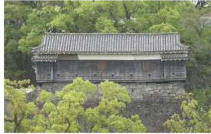
2 北面② 壁漆喰等に亀裂や剥落が見られる。
