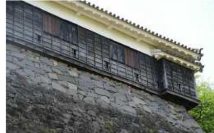
7 〈震災前〉北面③-1(石垣天端部) 土台と石垣天端が接している。
