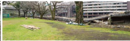
02 倒壊範囲 内側(H28.12撮影)
