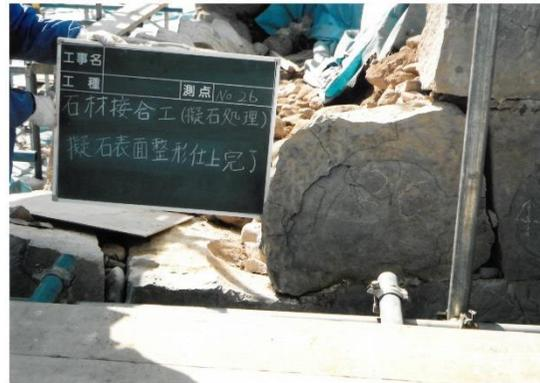
平成15年度本丸御殿部アンカーピン設置時擬石処理状況
