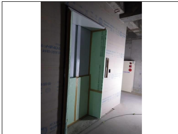
大天守5-6階 エレベーター設置状況
