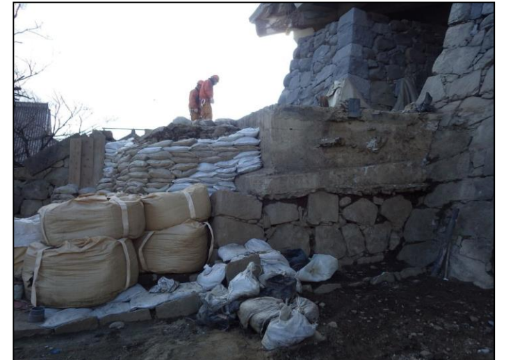
附櫓 基礎部解体状況
