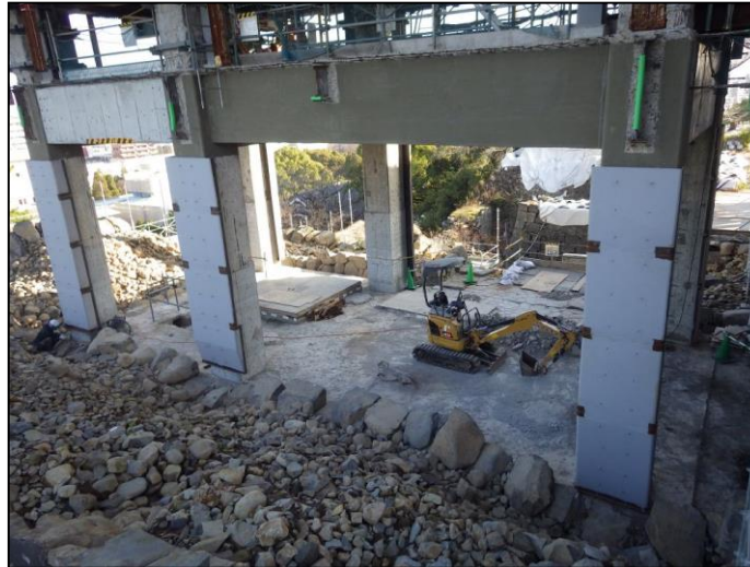
小天守B1階 柱鋼板巻施工状況
