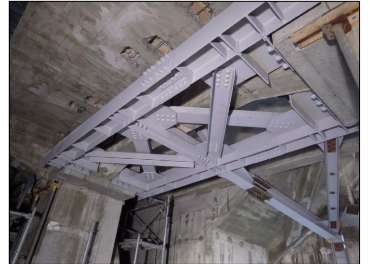
大天守2階 水平力伝達鉄骨施工状況
