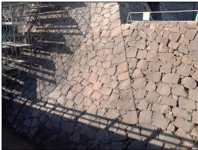
大天守 石垣復旧状況
