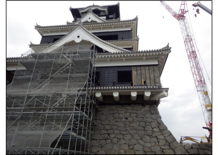
大天守南側 昇降足場取付状況
