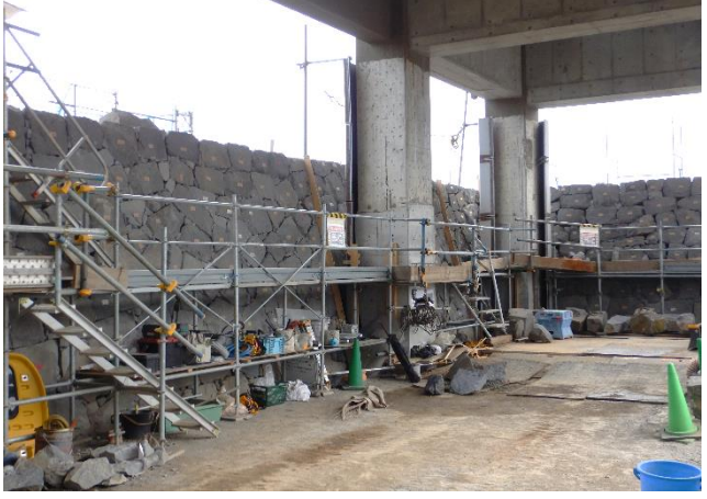
穴蔵西面・東面積み直し状況(2019.3月)
