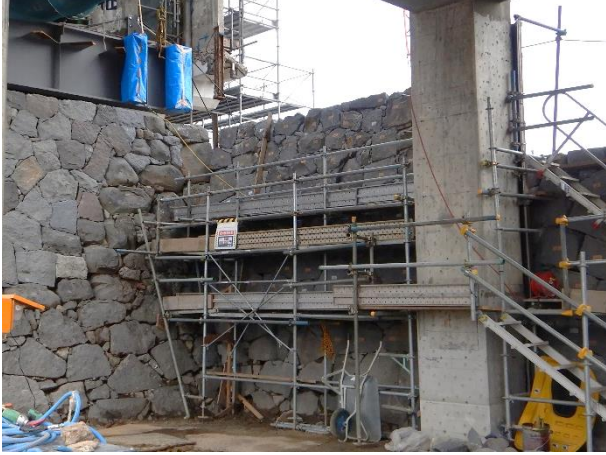
穴蔵西面積み直し状況(2019.3月)
