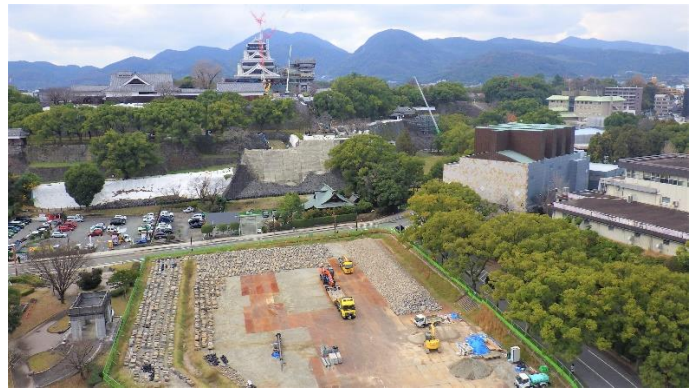
東 (ビル屋上) から
