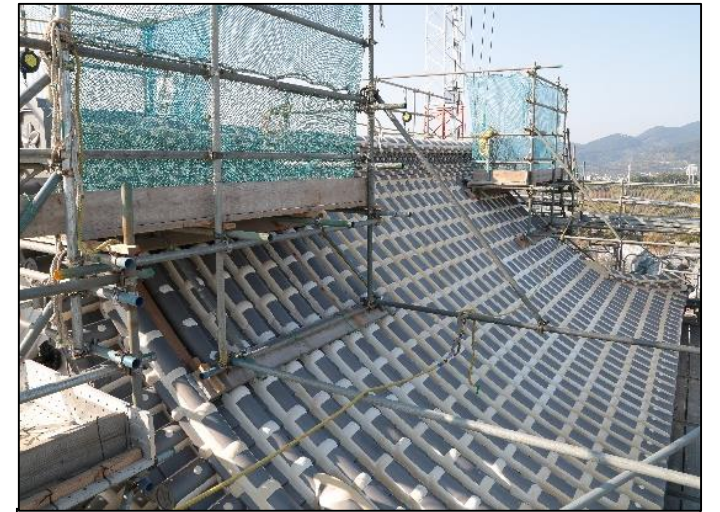
小天守 屋根施工状況
