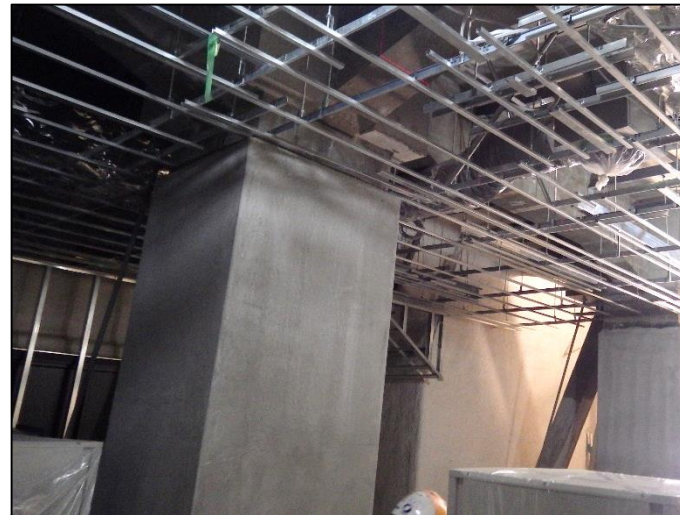
大天守 内装工事状況
