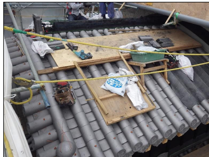
大天守 附櫓施工状況
