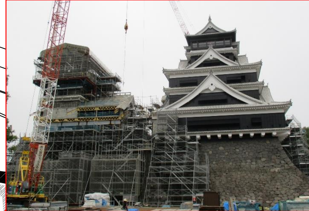
①天守閣復旧整備工事 【国交省・文化庁・県・日本財団・市】 H29.2月着手(継続:H28~R2事業)
