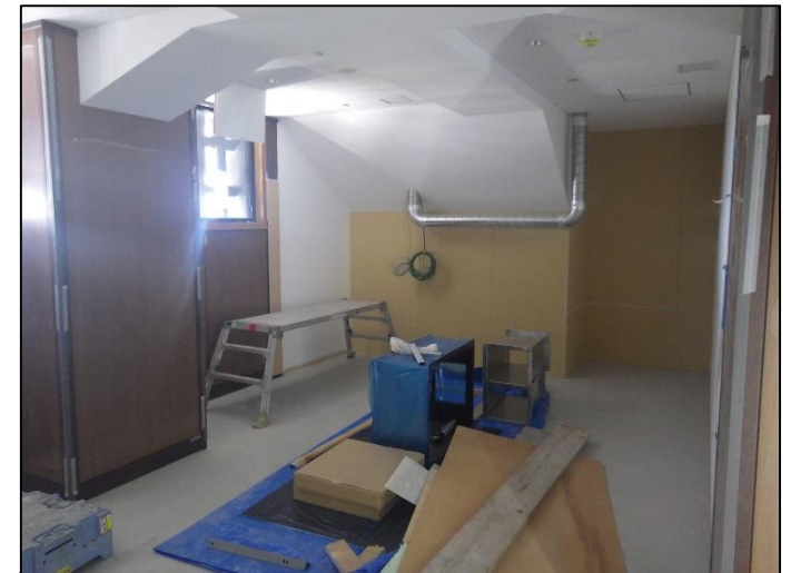
大天守 内装工事状況
