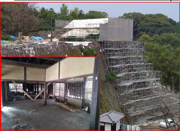
④平櫓解体保存工事【文化庁・市】 (継続:H30・R1事業)
