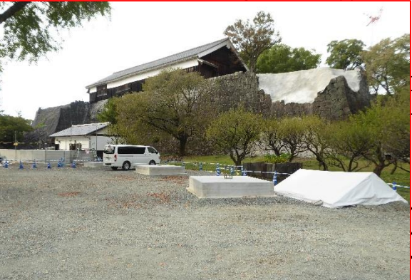
⑪特別見学通路設置工事 【日本財団・市】 H31.3月着手(継続:H30・R1事業)
