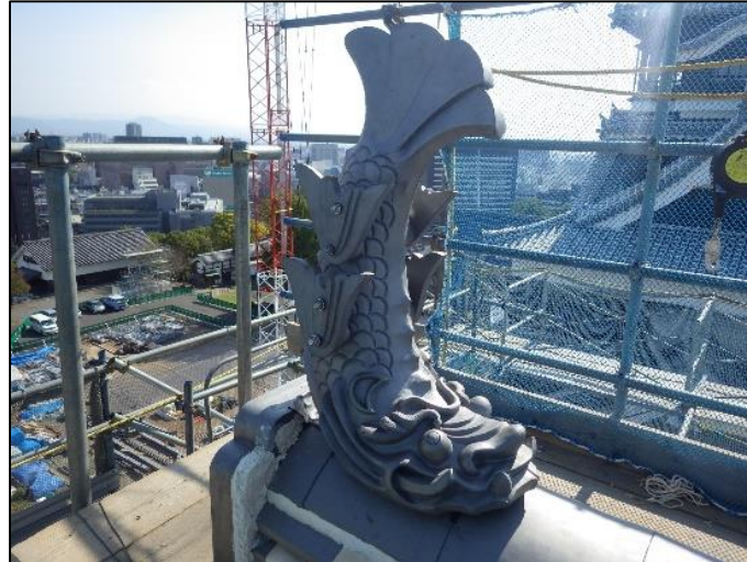
小天守 屋根施工状況
