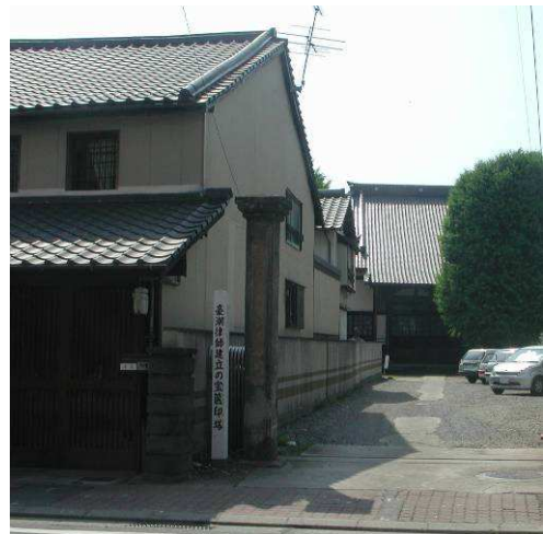
本堂の屋根と町屋／古町
