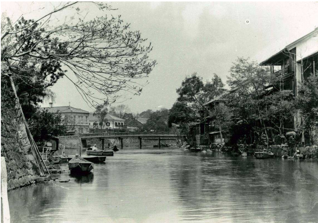
坪井川下流から見た洗馬橋付近 明治中期撮影 提供：富重写真所
