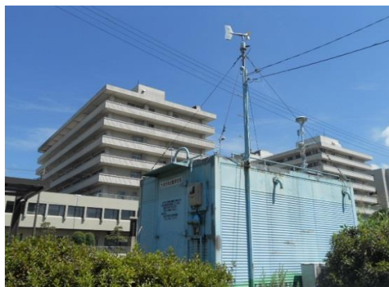
自動車排ガス測定局（神水本町局）
