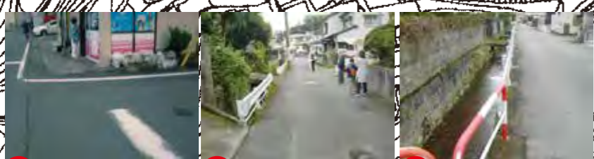
⑫ 大雨時、道路冠水する恐れあり ⑬ 大雨時、道路冠水する恐れあり ⑭ 大雨時、道路冠水する恐れあり
