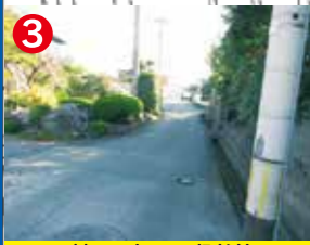
蓋の無い側溝
