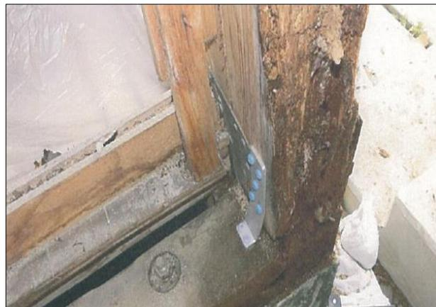
柱脚金物を設けていますが、柱が腐朽しているため、接合部IVとして評価しています。
