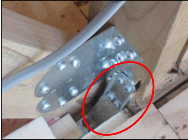
筋かい金物と柱脚金物が重なっており、正しく施工されていないため、（○の部分）柱の接合部をⅠ、Ⅱで評価できません。
