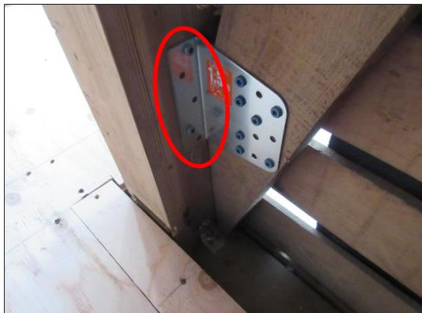
柱側のビスが正しく施工されていないため、（○の部分）耐力を 筋かい金物付きで評価できません。
