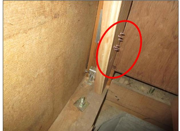
30×90 筋かいに 45×90 用の筋かい金物を使用しているため、耐力を 30×90 筋かい金物付きで評価できません。
